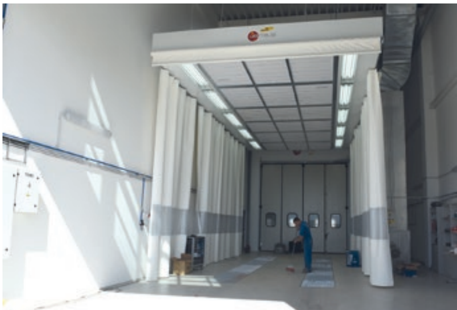
Камерата за боядисване, дълга 12 м, е с междинна ролетна врата, дяляща помещението на две автономни зони с дължини 4 + 8
