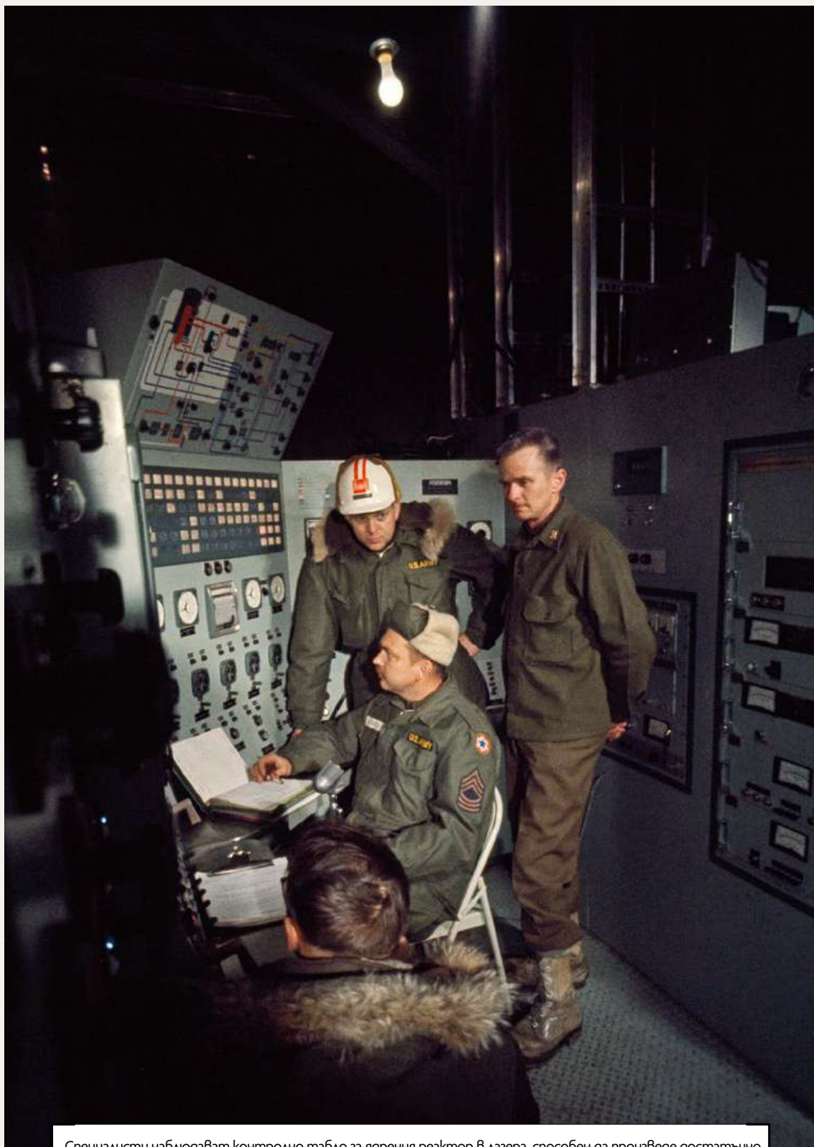
Специалисти наблюдават контролно табло за ядрения реактор в лагера, способен да произведе достатъчно топлина и светлина за над 500 среднестатистически американски домове по онова време – както и да спести огромни средства в сравнение с докарването на гориво до това отдалечено място.
